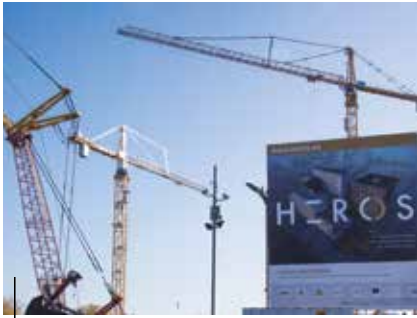
Vernieuwing Osdorpplein uit de startblokken
